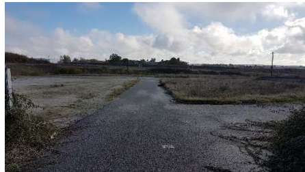
ANCIENNE ZONE DE TRAVAUX LGV
